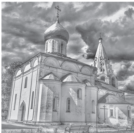
Ил. 1. Троицкий собор 1530–1532 гг. Данилова монастыря в Переславле-Залесском с приделом Даниила Переславского (на фото – одноглавая, с одной абсидой пристройка справа от основного объема храма) 1660 г.
